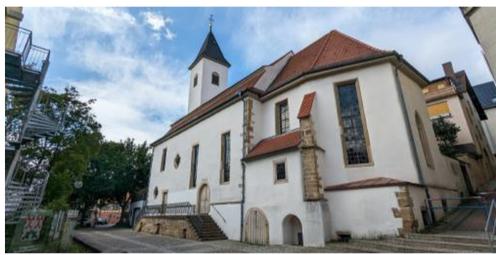
Baumaßnahmen an der Kreuzkirche in Bretten werden künftig nicht mehr aus landeskirchlichen Mitteln finanziert. Foto: hk
